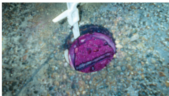
Figura 2 Medición de la carbonatación en el tablero
