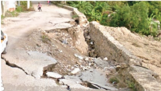
Figura 1. Colapso del muro en el año 2012
