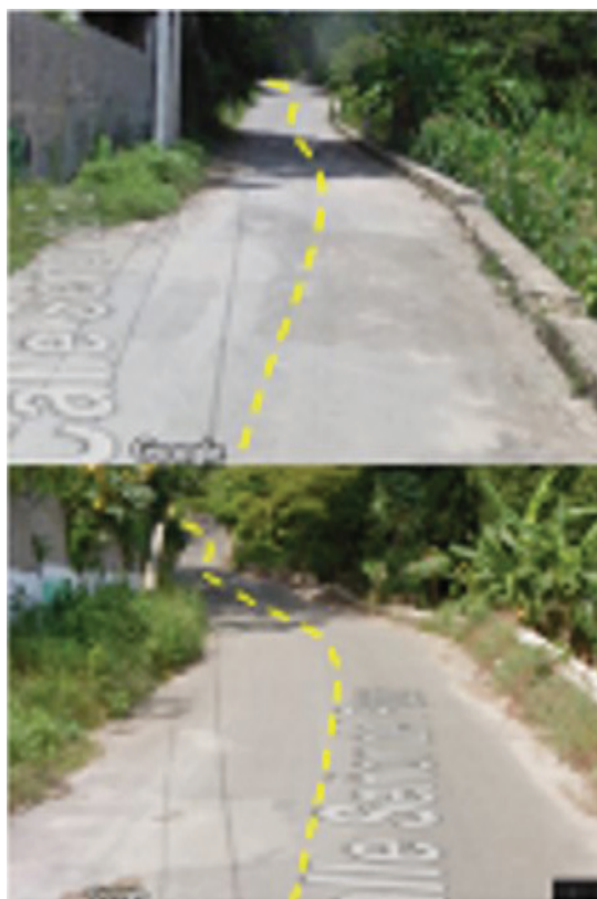
Figura 5. Comparación de la deformación de la vialidad (izq.2009-der.2017)
