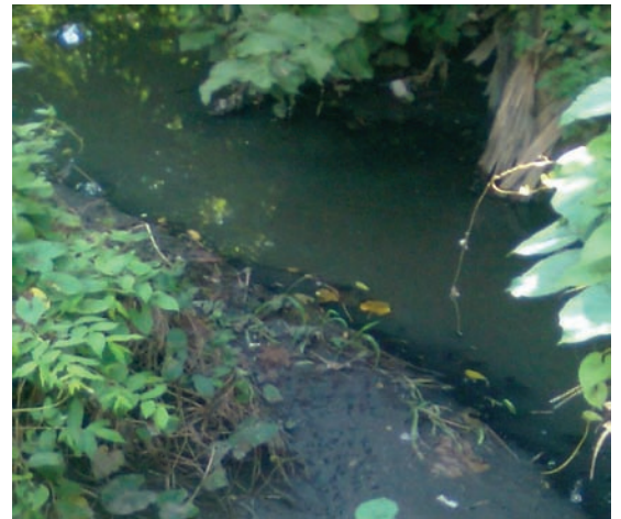
Figura 7. Canal de aguas negras proveniente del Ejido Morelos.
