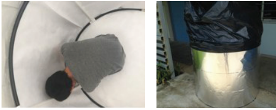
a) Superficie interna del tanque, siendo cubierta con papel Tyvek, usando una estructura de pvc b) Superficie externa del tanque, cubierta con 10 capas de plástico negro más 2 capas de aluminio más 2 capas más de plástico.
