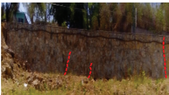
Figura 2. Grietas actuales en el muro de mampostería
