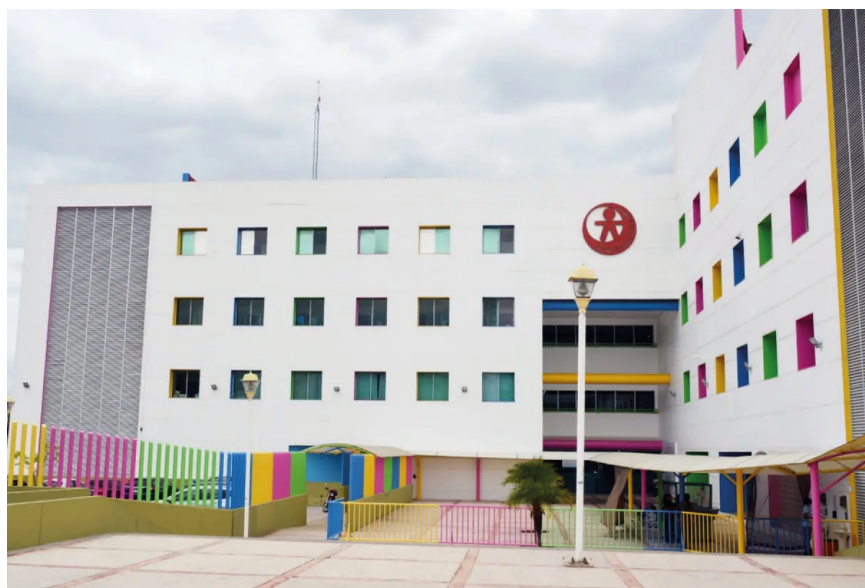
Hospital de Especialidades Pediátricas de Tuxtla Gutiérrez
