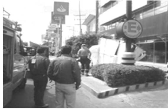
Figura 4b. Daño a estructura de espectacular ubicado en lo alto de un edificio en el Boulevard Belisario Domínguez, en la zona norte poniente de Tuxtla Gutiérrez, Chiapas durante el año 2009.
