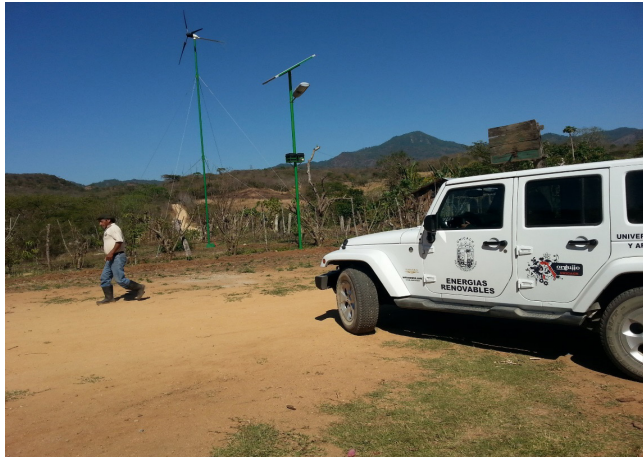
Imagen 12. Visita a los aerogeneradores en Villa del Río
