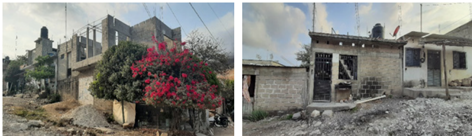
Figura 2. Viviendas con muros de bloque en Los Yuquis
